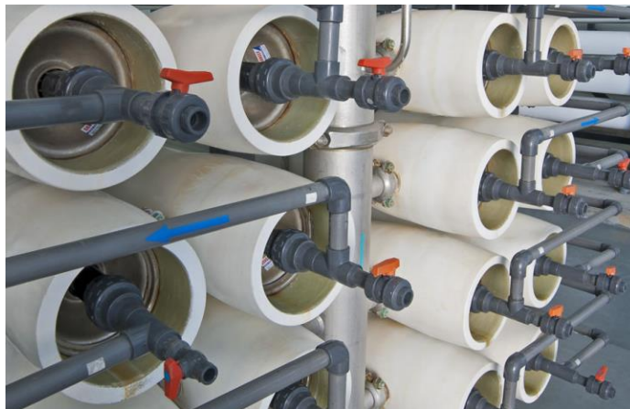
Gambar 6. Instalasi teknologi filtrasi berbasis nanoteknologi
