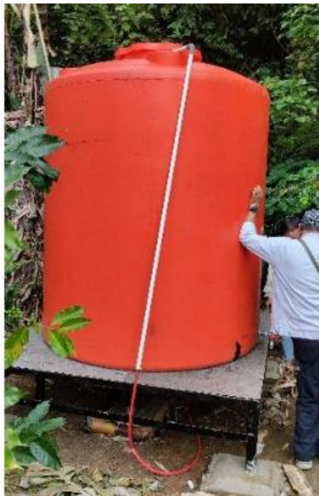
Gambar 4. Tangki Penampungan Air
